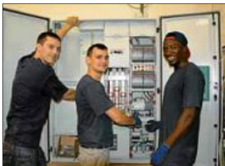
Arbeit am Schaltkasten in der Thiebauthschule in Ettlingen: Bubakar Conteh zusammen mit SWE-Mitarbeiter Marcel Ruck und Bauleiter Florian Oebel (von rechts).
